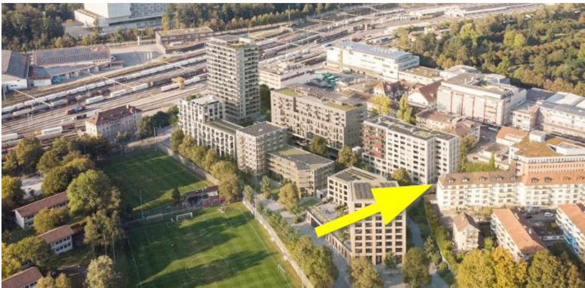
Abb. 1: Überbauung «Holliger» mit der Lage der beiden Basisstufen inkl. Aussenraum
