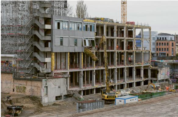
**Zuerst wurde das Kakaobohnensilo abgebrochen und das alte Lagerhaus komplett ausgehöhlt. Nur die tragenden Stützen, Decken und unterirdischen Aussenwände blieben bestehen.**
