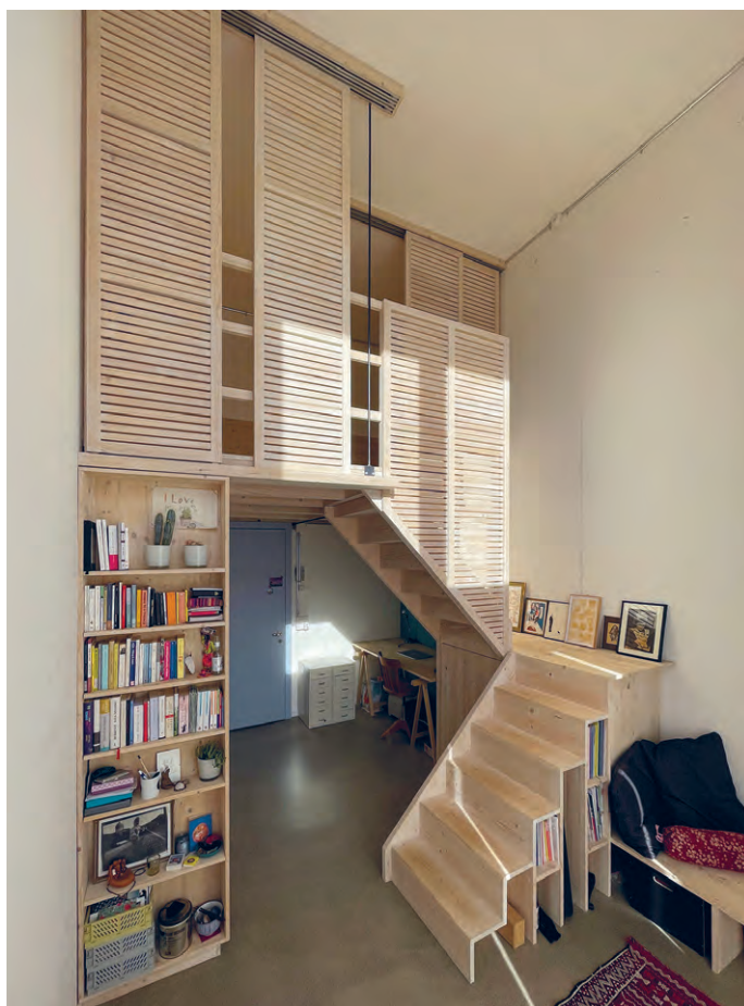
Dank der Raumhöhe von 4,7 Metern wurde ein zweiter Stock in diesem WG-Zimmer eingebaut, der als «Hochbett» benutzt wird. Diesen Ausbau haben die Bewohner*innen selbst umgesetzt und finanziert.
